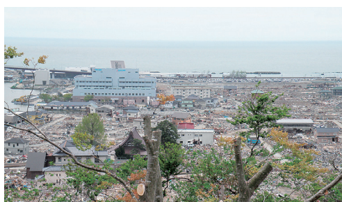
5月12日12時頃 石巻市日和山より。地震発生から2カ月経ったが、発生直後の様に見える。形を残す家屋も、屋根の上まで水が通った後があり、地盤沈下により一部道路は浸水していた。左奥に見える青い建物が、石巻市立病院である。
