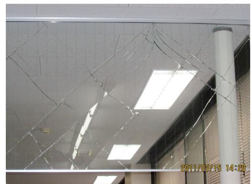
写真9 防煙ガラス破損の写真
