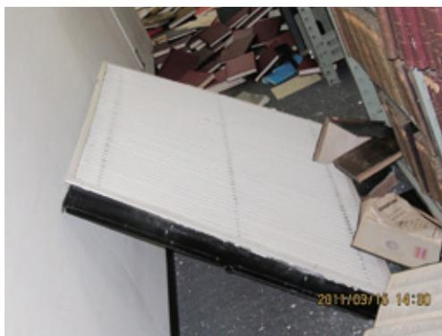
写真4 天井及びダクトの落下写真(3)
