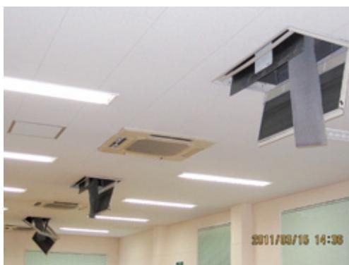
写真2 天井及びダクトの落下写真(1)
