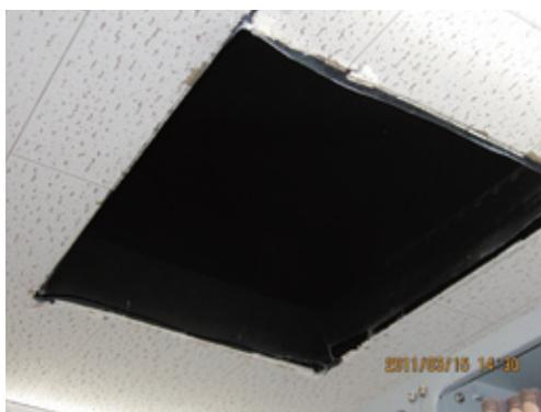
写真3 天井及びダクトの落下写真(2)
