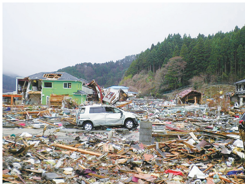
写真6 石巻市雄勝地区中心部の被災状況
