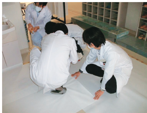
図1 PET棟の一部を養生
