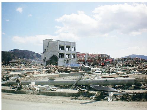
写真3 南三陸町志津川地区の被災状況
