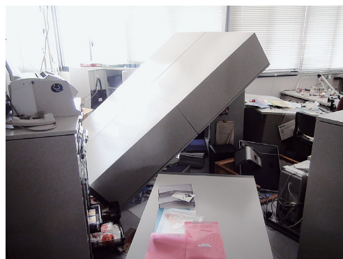
震災翌日の5号館8階環境保健医学分野事務室。耐震対策を施していた棚が倒れ、机上のパソコンも落下した。
