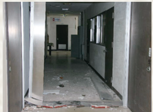
3月12日 1号館2階廊下の被害
