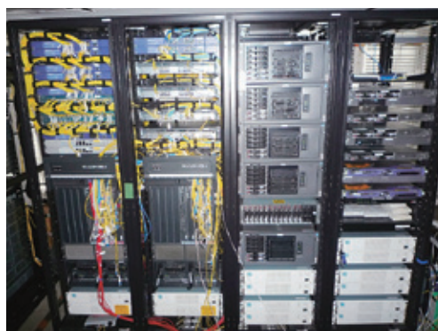
図2 大学病院ラック
