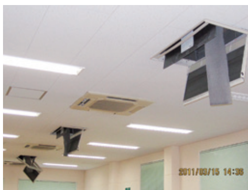
写真2 天井及びダクトの落下写真(1)
