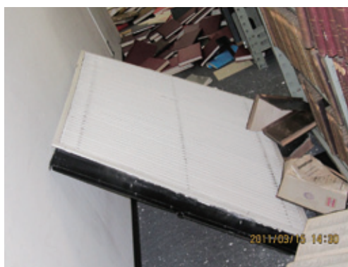
写真4 天井及びダクトの落下写真(3)
