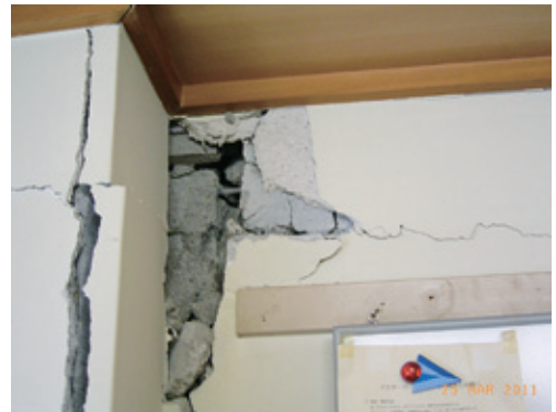
写真 12 壁が激しく破損。柱は問題ないので安全との事。
