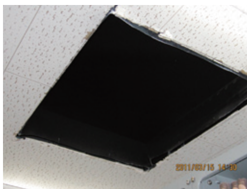
写真3 天井及びダクトの落下写真(2)
