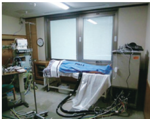
写真1 スキルスラボ被害の様子。廊下からの水漏れによりラボ1の床は水浸し。シミュレーターを部屋の隅に移動した。
