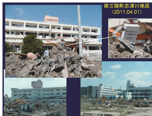
南三陸町公立志津川病院の被災状況 (2011年4月1日巡回診療時に撮影)
