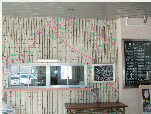
写真4 玄関ロビーから見る警務員室。壁に貼り巡らされたテープはひび割れなどの損傷部位を示しており、今後の修復工事の際に利用されます。
