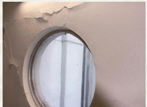
3月12日 大きなひび割れの入った1号館の窓枠
