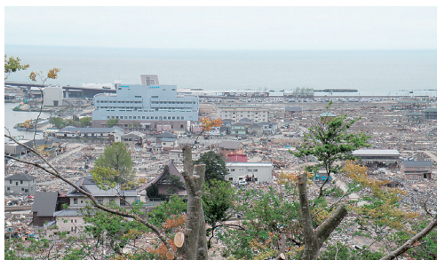
5月12日12時頃 石巻市日和山より。地震発生から2カ月経ったが、発生直後の様に見える。形を残す家屋も、屋根の上まで水が通った後があり、地盤沈下により一部道路は浸水していた。左奥に見える青い建物が、石巻市立病院である。
