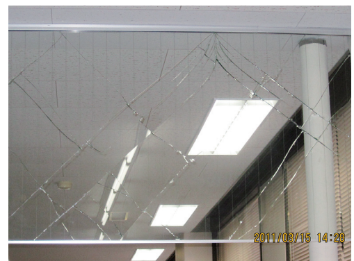
写真9 防煙ガラス破損の写真
