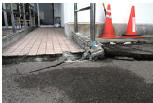
写真3 保健管理センター玄関の地割れ、陥没
