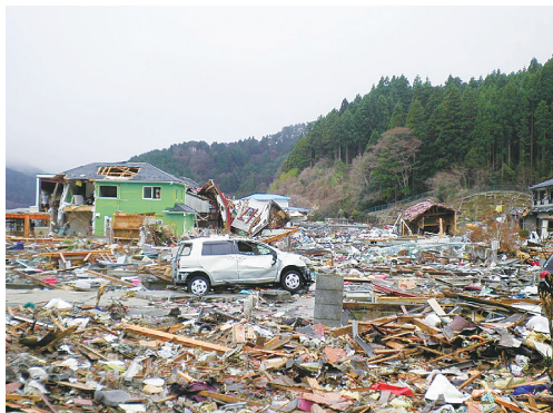
写真6 石巻市雄勝地区中心部の被災状況
