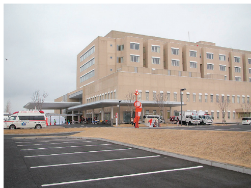
写真7 石巻赤十字病院の外観。石巻近辺で機能できた唯一の病院である。病院全体が免震構造であり、広大な駐車場とヘリポートを装備している。病院は盛土の上立っているため、津波被害を免れたが、周辺は完全に水没していた。
